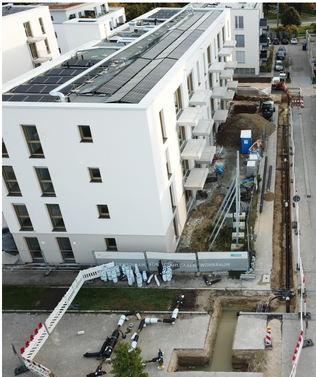
Pressefoto FIDES Gruppe: Bauarbeiten im Rahmen der öffentlichen Erschließung im Ernst-Bauer-Weg Ecke Peter-Ury-Weg
