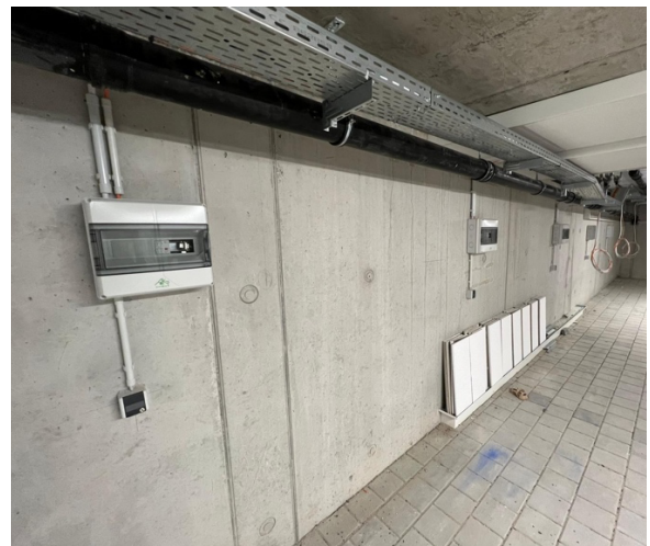
Pressefoto FIDES Gruppe: Tiefgaragenstellplätze mit Lademöglichkeit für Elektrofahrzeug und einer herkömmlichen Schuko-Steckdose
