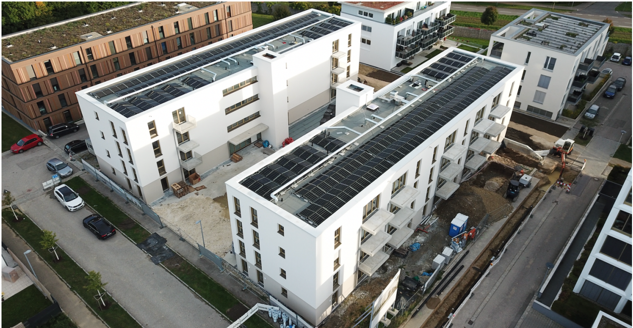
Pressefoto FIDES Gruppe: Photovoltaikanlage auf dem Dach der zwei Gebäudekomplexe im Ernst-Bauer-Weg
